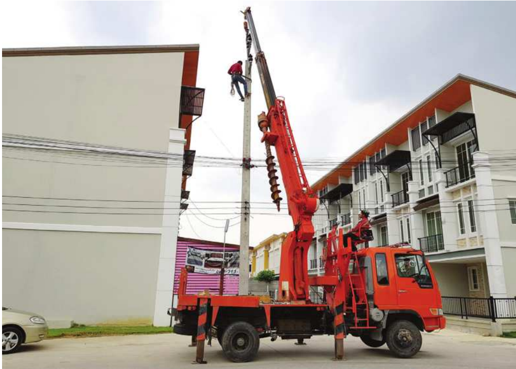
Görsel 7.15: Aydınlatma direğinin dikilmesi
