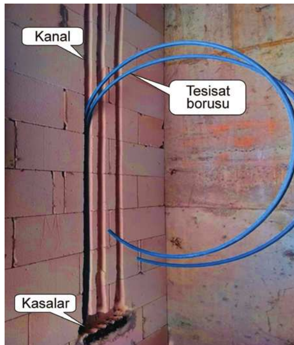
Görsel 2.49: Tesisat boru montajı
