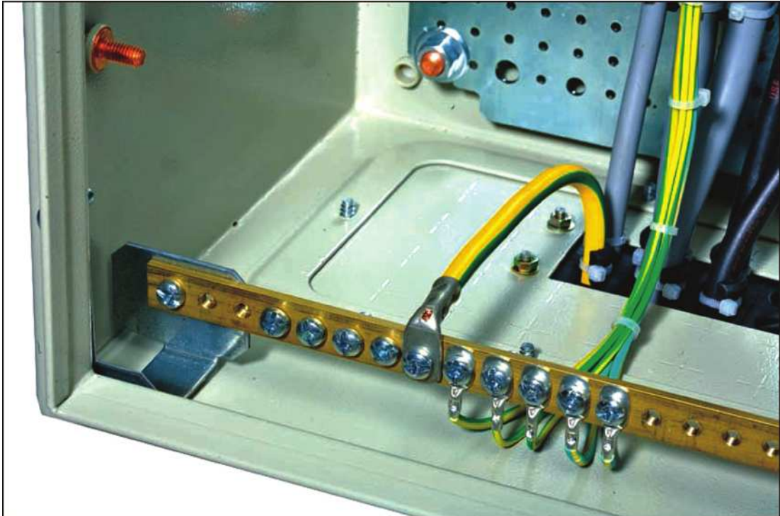
Görsel 1.26: Topraklama iletkeninin pano topraklama barasına bağlantısı
