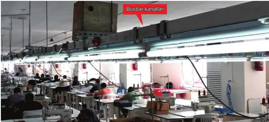
Görsel 3.5: Bir atölyenin busbar sistemi
