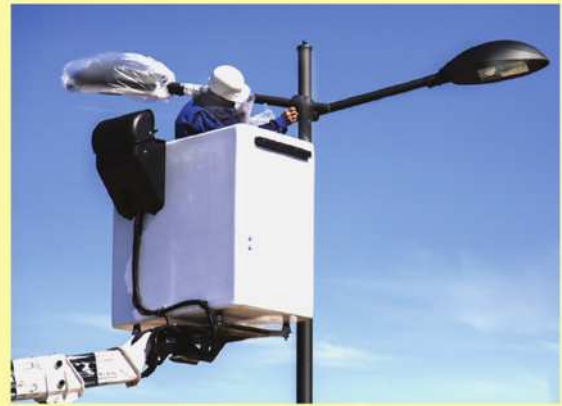
b) Aydınlatma armatürünün montajı
