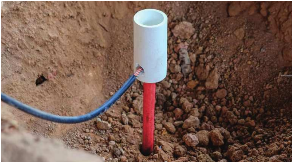
Görsel 1.11: Topraklama kazığının çakılması
